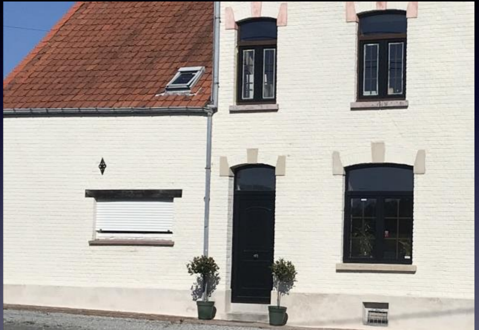
Peinture silicate et plinthe à la chaux
