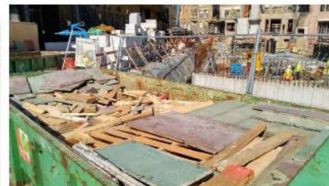
APRES intervention du gardien de chantier
