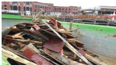
AVANT intervention du gardien de chantier
